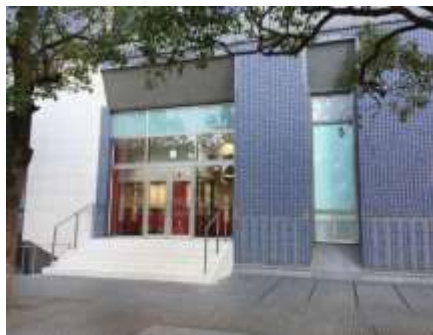
スポーツジム専用の入口を新設
