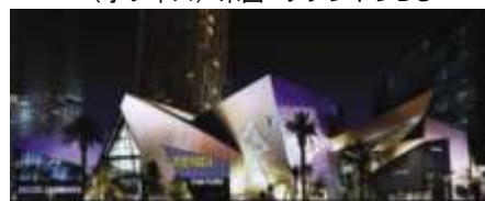
(商業施設) 米国 ネバダ州 ラスベガス
