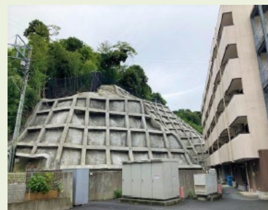
【対策工事実施後】
