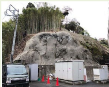
【対策工事実施前】
