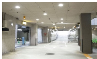
大川端賃貸棟 (駐車場)
