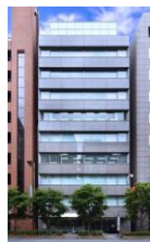
KDX新日本橋駅前ビル
