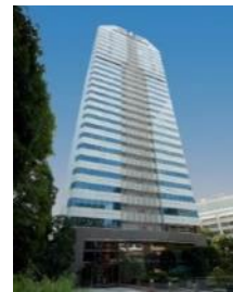
紀尾井町ビル
