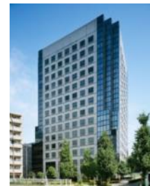
大崎MTビル
