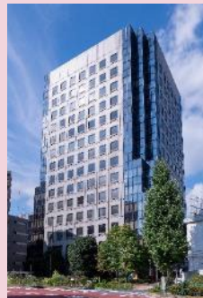
大崎MTビル
