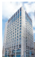
KDX横浜関内ビル
