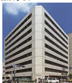
パシフィックマークス 肥後橋
