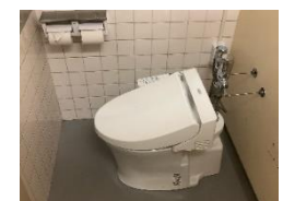
（トイレ設備更新工事）
