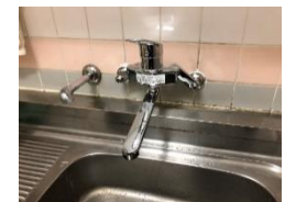
（混合水栓更新工事）
