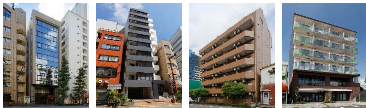
●リードシー御殿山 ●リードシー飯田橋 ●シルフィード東品川 ●ロイヤルブルーム
