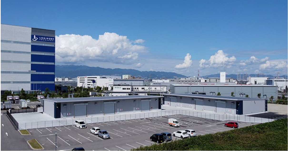
参考資料 1 外観（本増築部分）
