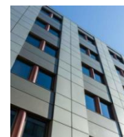
A-23 イトピア 若本町ANNEXビル
