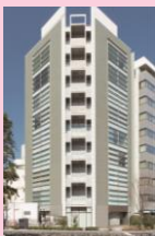
A-59 友泉東日本橋 駅前ビル
