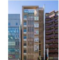
C-1 小滝橋パシフィカビル
