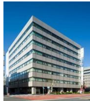
A-39 イトーピア 清洲橋通ビル
