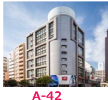
A-42 サンワールドビル
