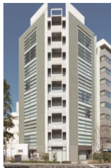
A-59 友泉東日本橋駅前ビル
