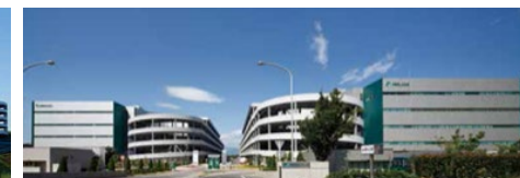
M-10 プロロジスパーク座間2 M-02 プロロジスパーク座間1
