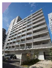
●シティビルズ安堂寺
