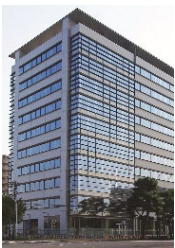
A-18 晴海センタービル
