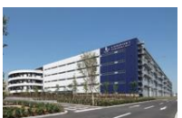
ロジポート川崎ベイ 2019年度竣工 296千㎡
