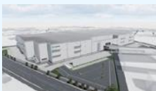
ロジクロス蓮田* 2020年度竣工予定 79千㎡
