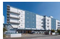
MJロジパーク船橋1 18千㎡
