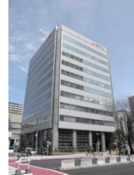
事C-12 損保ジャパン仙台ビル
