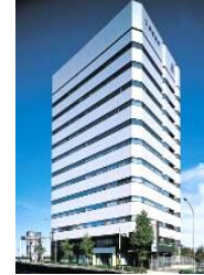
事B-5 新横浜第二センタービル
