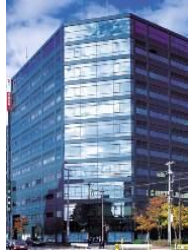
事C-1 新潟駅南センタービル
