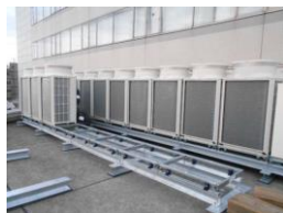
空調設備の更新
