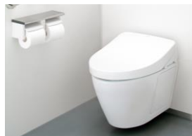
トイレのリニューアル工事
