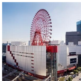
観覧車のリニューアル工事を実施 (HEPファイブ)
