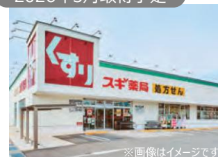
(仮称) スギ薬局大東御領店 (敷地)
