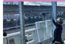
窓への遮熱塗料コーティング
