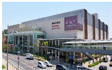
外壁改修工事の実施 (阪急西宮ガーデンズ)
