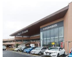
オアシスタウン伊丹 鴻池（敷地）
