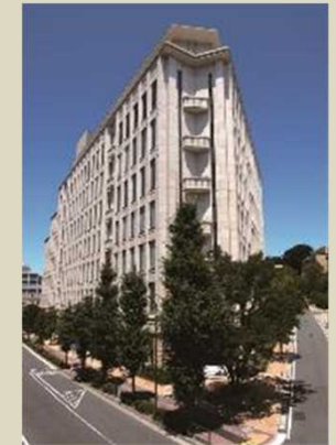
御殿山SHビル
