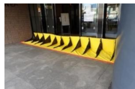
止水板又は土嚢等の常備
