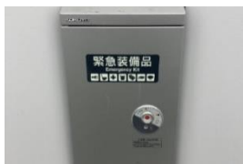
防災備品の設置
