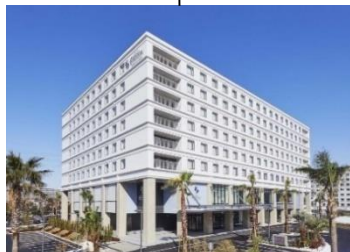
ホテルエミオン東京ベイ新館 千葉県浦安市 ホテル 2018年9月竣工
