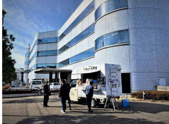
IIF品川データセンター
