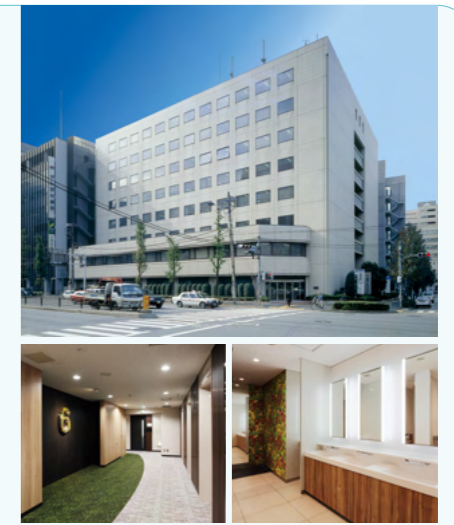
エレベーターホール改修後 トイレ改修後
