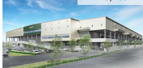
プロロジスパーク古河4 (茨城県古河市) 2023年3月竣工予定
