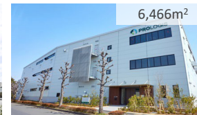
プロロジスアーバン 東京足立2 (東京都足立区) 2022年3月竣工
