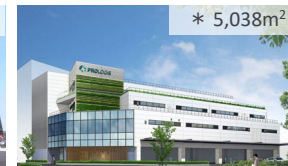
プロロジスアーバン 東京大田1 (東京都大田区) 2023年2月竣工予定
