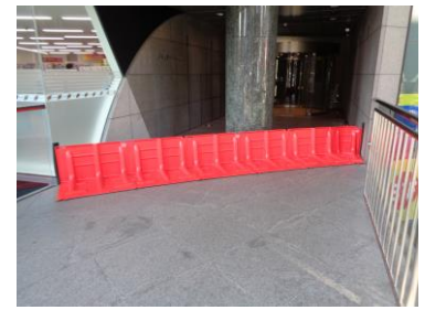
(JPR上野イーストビル エントランス)
