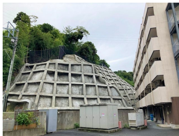
工事実施後（2022年9月 竣工）
