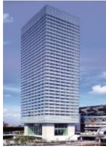
明治安田生命 さいたま新都心ビル (埼玉県さいたま市)
