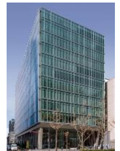
明治安田生命 大阪御堂筋ビル (大阪府大阪市)
