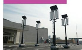
風車とソーラーパネルのハイブリッド型発電設備の設置 (エネルギー使用量削減)
