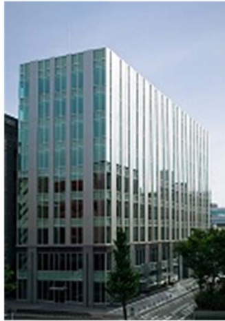
博多駅前スクエア (福岡県福岡市)
