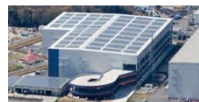
太陽光パネルの設置
