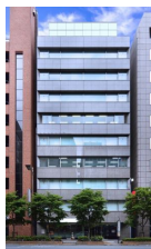
KDX新日本橋駅前ビル
