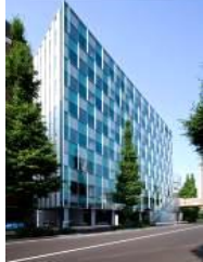
事A-21 JPR千駄ヶ谷ビル
