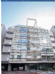
事A-2 兼松ビル別館
