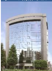
事A-15 南麻布ビル
