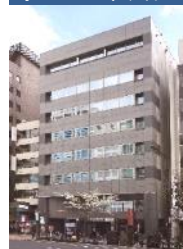
事A-9 JPR市ヶ谷ビル
