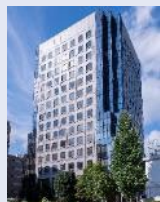
大崎MTビル
