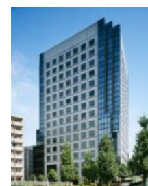
大崎MTビル
