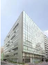
事A-20 JPR日本橋堀留ビル
