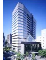
事B-6 川口センタービル
