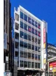
商A-7 FUNDES水道橋
