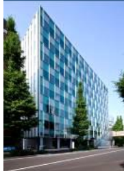
事A-21 JPR千駄ヶ谷ビル
