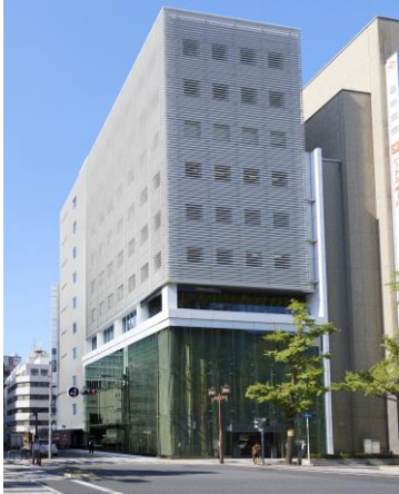
事C-21 JPR心斎橋ビル
