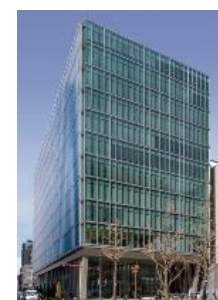
明治安田生命 大阪御堂筋ビル (大阪府大阪市)
