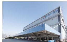
IIF 大阪茨木ロジスティクスセンター
