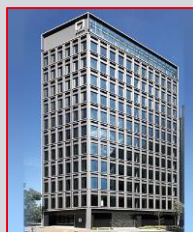
S-GATE日本橋本町
