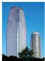
愛宕グリーンヒルズ (MORIタワー)
