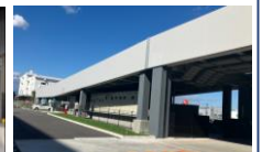
2階へ直接乗入れ可能なスロープ
