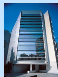
写真：フォワードストローク アーバンネット 日本橋ビル 延床面積：3,473.99㎡
