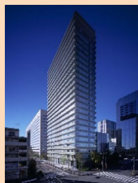
ウエリスアーバン 品川タワー 延床面積：16,657.11㎡
