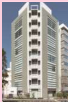
A-59 友泉東日本橋駅前ビル (東京都中央区)
