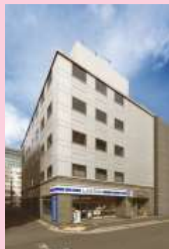
A-58 藤和神田錦町ビル (東京都千代田区)
