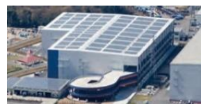
太陽光パネルの設置
