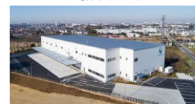
物流総合効率化法に基づき テナント協働でCO2削減を推進
