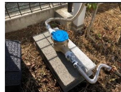
自動散水栓にサブメーターを設置し、より詳細の水使用量を把握し、節水施策につなげる
