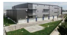
緑化駐車場の設置
