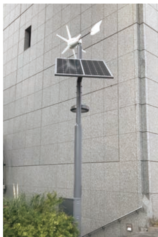
ソーラーウインド街路灯の設置 (Daiwaリバーゲート)
