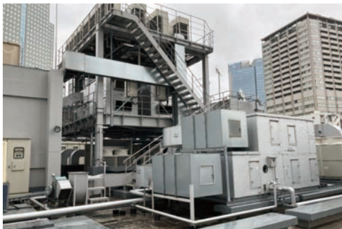
空調設備の更新 (Daiwa赤坂ビル)
