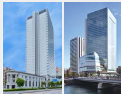
JMFビル横浜馬車道01 (左)、 横浜市役所 (右)
