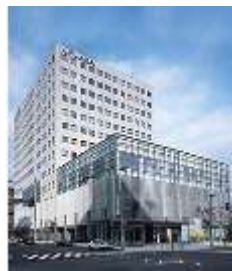
【札幌エルプラザ】
