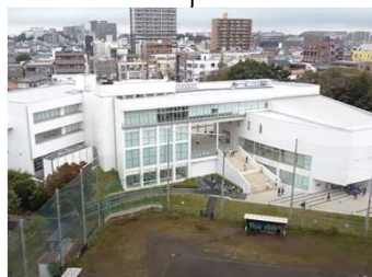
習志野市 大久保地区公共施設再生事業 千葉県習志野市 公共施設(図書館・市民ホール・公民館)・公園・駐車場・民間付帯施設 2019年11月開業
