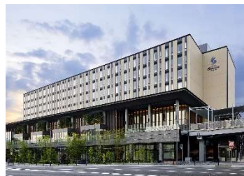
京都市中央卸売市場第一市場「賑わいゾーン」活用事業 京都府京都市 ホテル・商業 2020年7月開業
