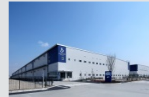
LP堺 (マルチ) 2017年4月竣工 稼働率100% (2)
