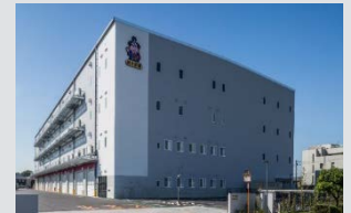
LP堺南島町 (BTS) 他BTS2物件 全て稼働率100% (2)
