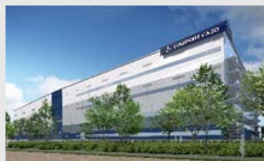
ロジポート加須 2021年5月竣工予定
