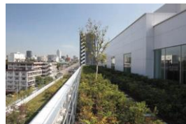
屋上庭園の設置 (Daiwa麻布テラス)
